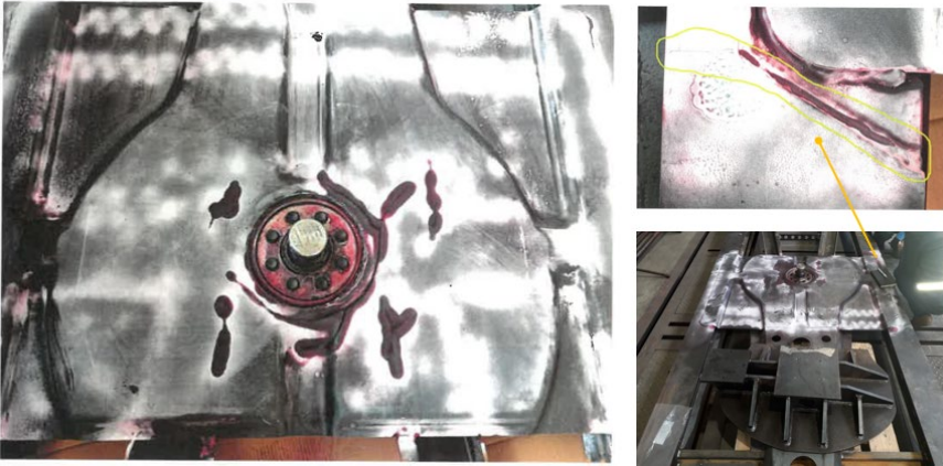
Rys. 8. Stan układu po zakończeniu badań. Pęknięcie w obszarze sworznia królewskiego oraz na połączeniu pasów dolnych podłużnicy
